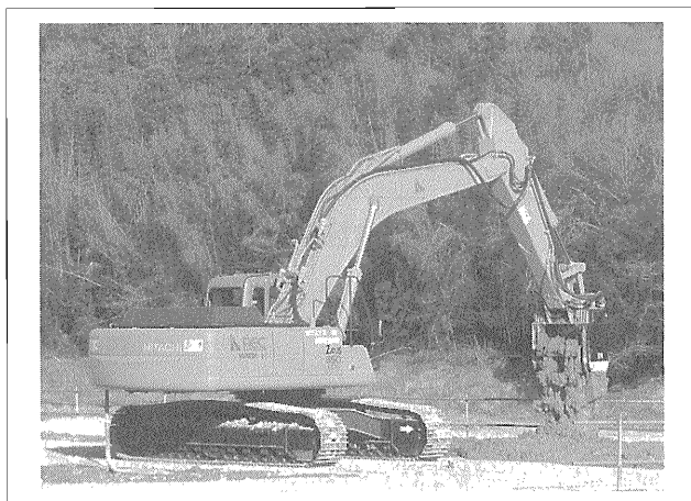
写真—2 トレンチャーによる初期固化状況
