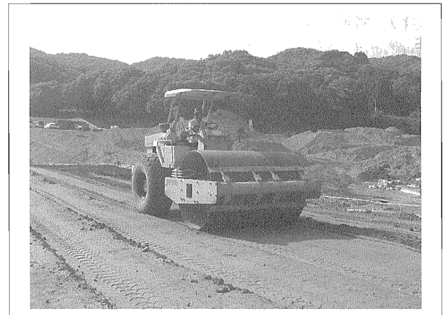
写真—5 振動ローラによる転圧状況
