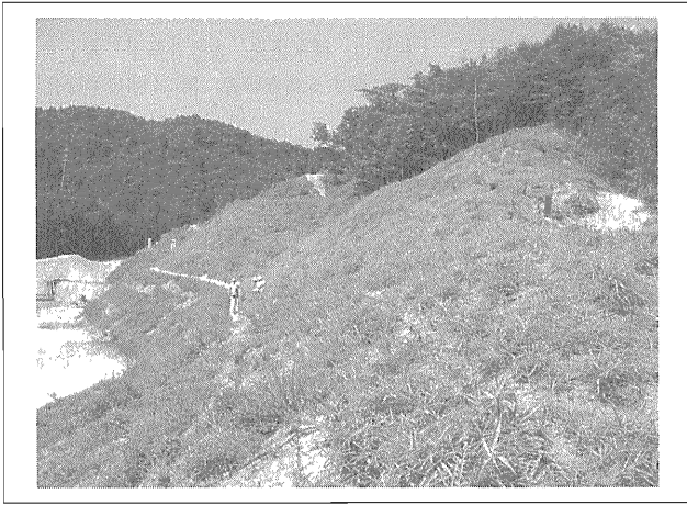
写真—9 施工後約2年経過（平成16年6月）
