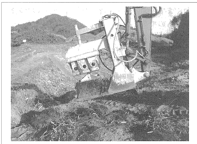
写真—3 採取機による表土マット採取状況
