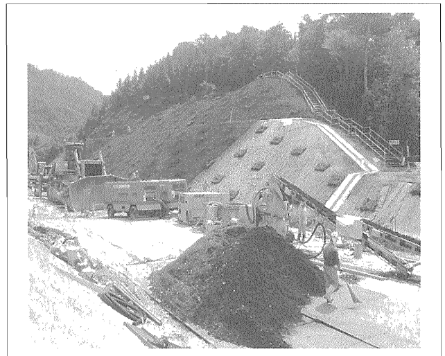
写真—12 建設発生木材と表土を混合した基盤材の吹付け
