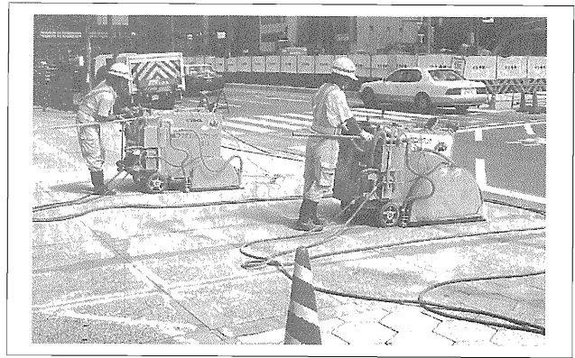
写真—6 コンクリート舗装（切断作業）
