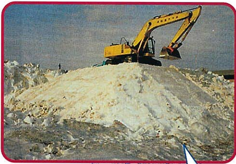
バックホウによる雪山の成型
