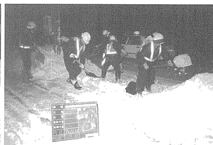
写真-6 人力施工（施工中）
