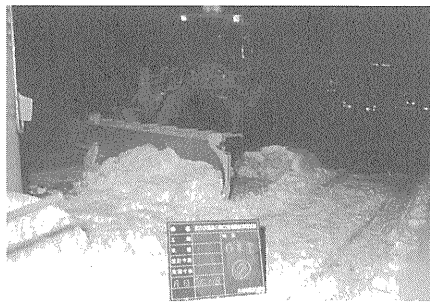
写真-9 機械施工（施工中）
