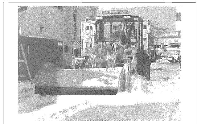
写真—14 拡幅後、路面整正する LX 80 RS 凍結路面切削装置付きの作業状況
