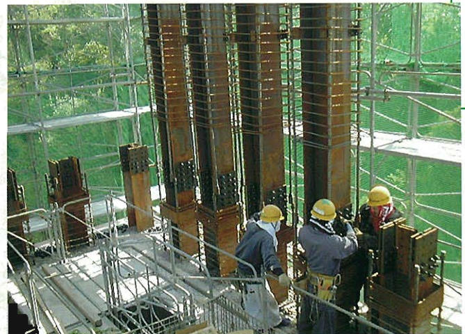
⇨ スパイラルカラムの設置状況2: 所定の位置に設置されたスパイラルカラムは高力ボルト、ねじ式継手により連結されます。
