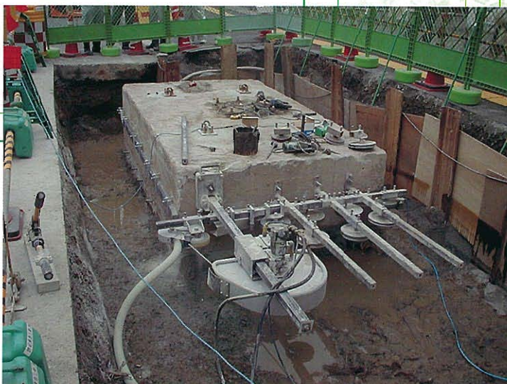
⇩ 国道の中央分離帯内工事
