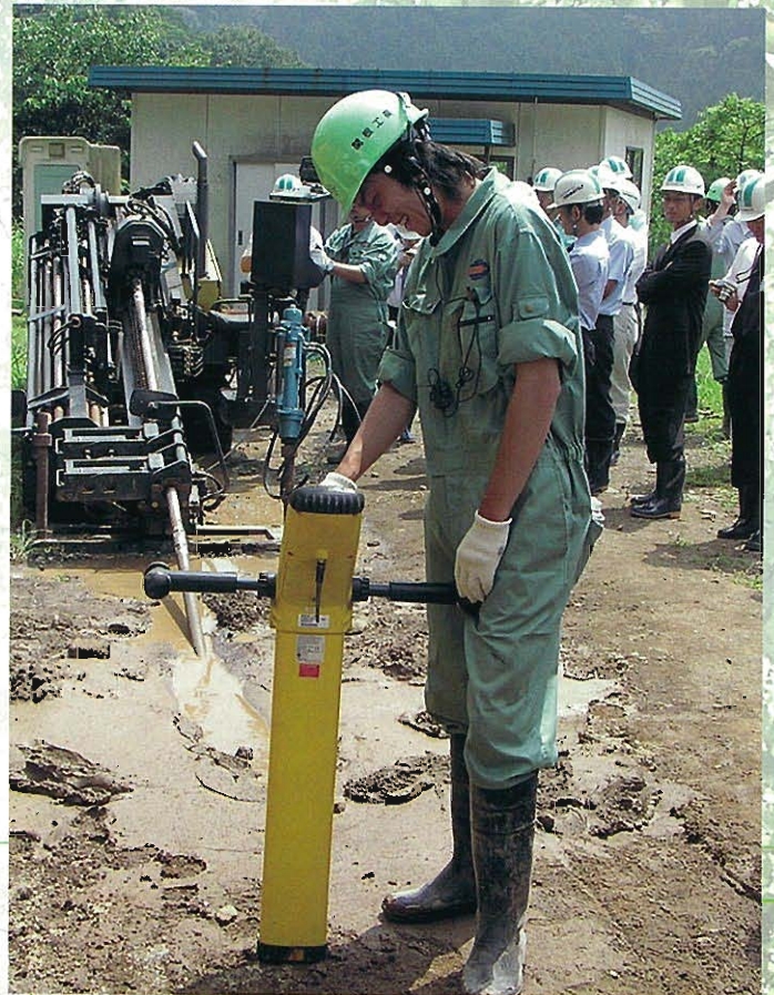
⇩ HDD (誘導式) 水平ドリル、ロケーター位置計測
