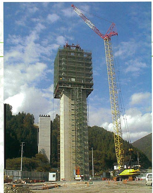
⇨ 昇降式移動型枠を用いた3H工法の施工 (洞泉橋)
