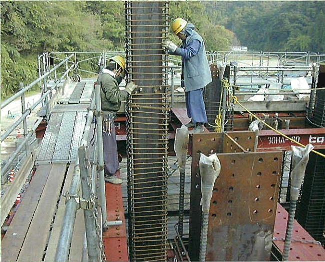
⇨ スパイラルカラムの設置状況1: クレーンで吊上げたスパイラルカラムを作業員が所定の位置に設置します。
