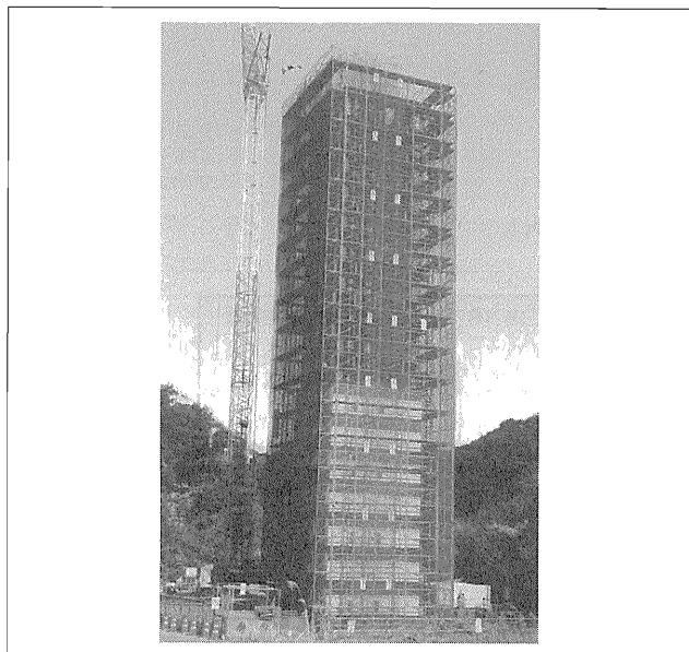
写真一六 3H工法による高橋脚工事全景 (飯牟礼2号橋)
