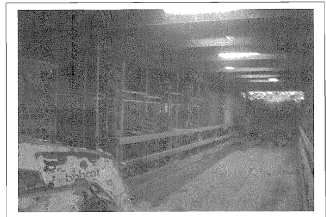
写真—3 床板支持力を向上させるためのサポート
