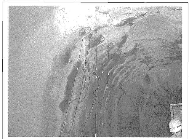
写真-6 防火扉戸溝掘削の施工前
