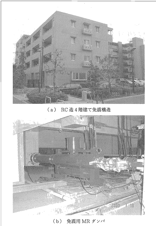
写真-2 免震構造のMRダンパ実施例 (神戸大・藤谷秀雄氏提供)
