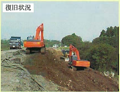
復旧状況 ↑写真-2 / 応急復旧工事 (3点とも本文の参考文献1)より
