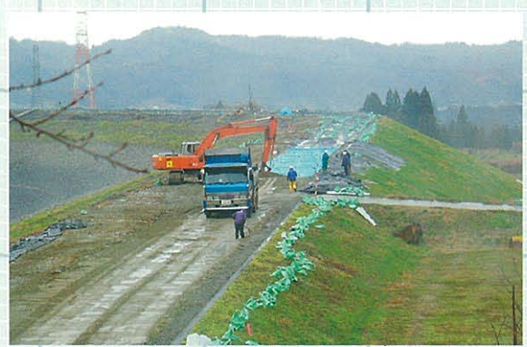
↑写真-6 / 新山本調整池天端覆土
