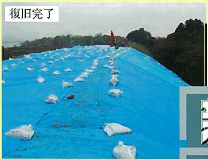
復旧完了 ↑写真-3 / 応急復旧後の状況
