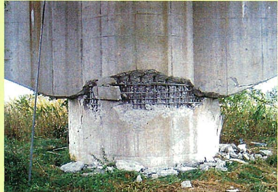
写真-13 / 橋軸直角方向の面 (写真提供: 国交省)
