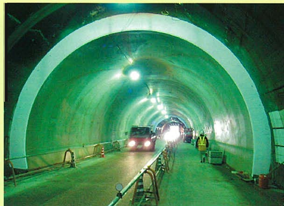
写真-17 / 二次覆工コンクリート (写真提供: 国交省)
