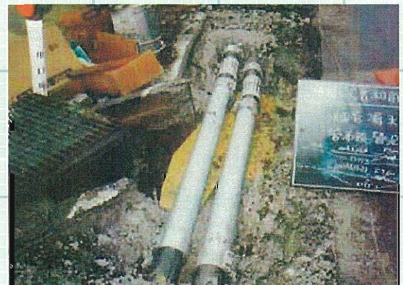
⇩写真-25 / フレキシブル管の挿入状況
