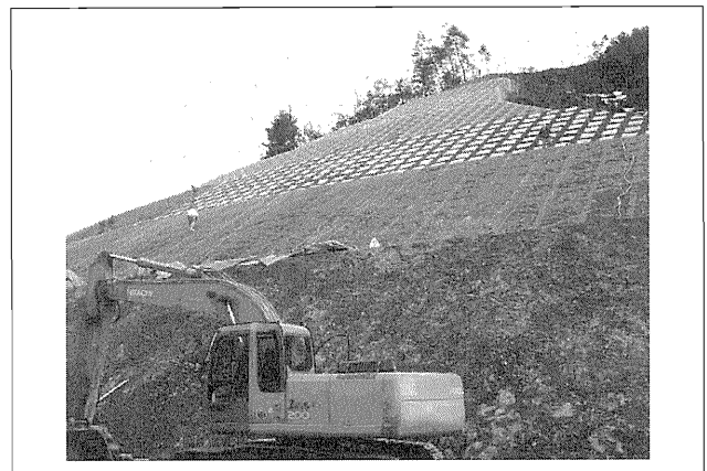
写真-1 のり面切り土工の実証実験
