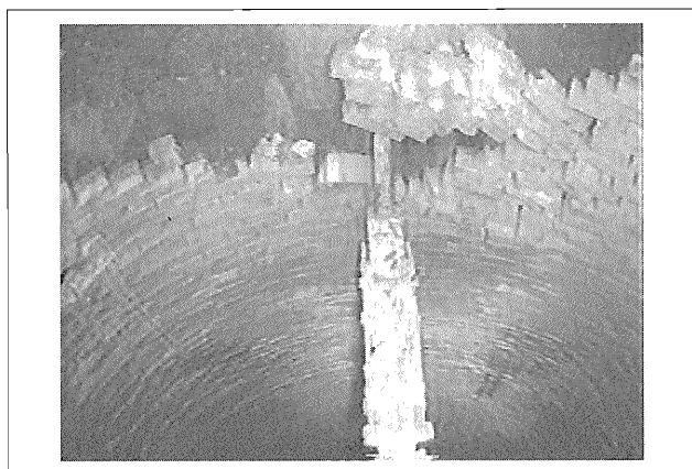
写真-4 耐火煉瓦の解体状況
