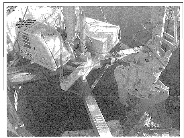
写真-6 コンクリート躯体の解体状況
