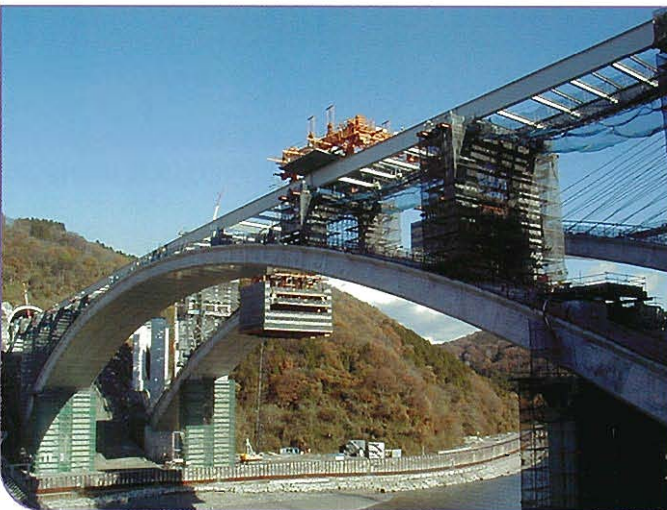
↑PC床版架設足場
