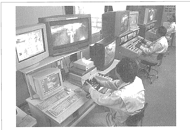
写真-1 函内掘削機遠隔操作状況
