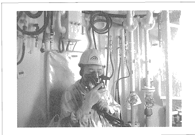
写真-3 酸素減圧状況 (混合ガスマンロック内)
