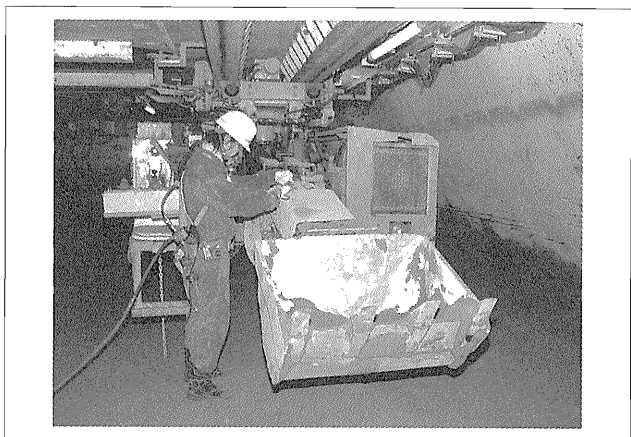
写真-6 ヘリウム混合ガス呼吸による函内作業状況
