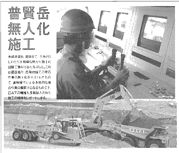
図-11 究極の安全作業：無人化施工
