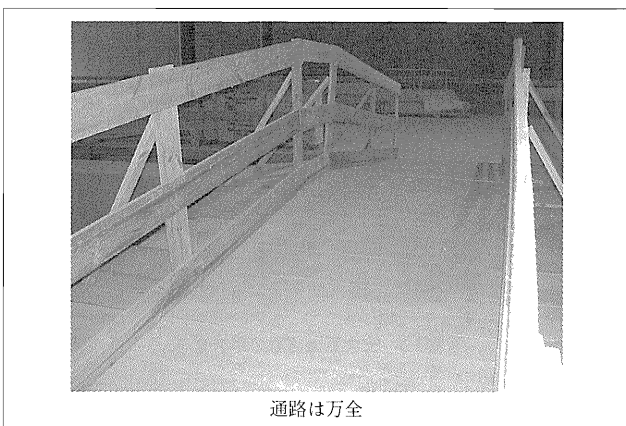
通路は万全 写真—5 通路養生の安全設備
