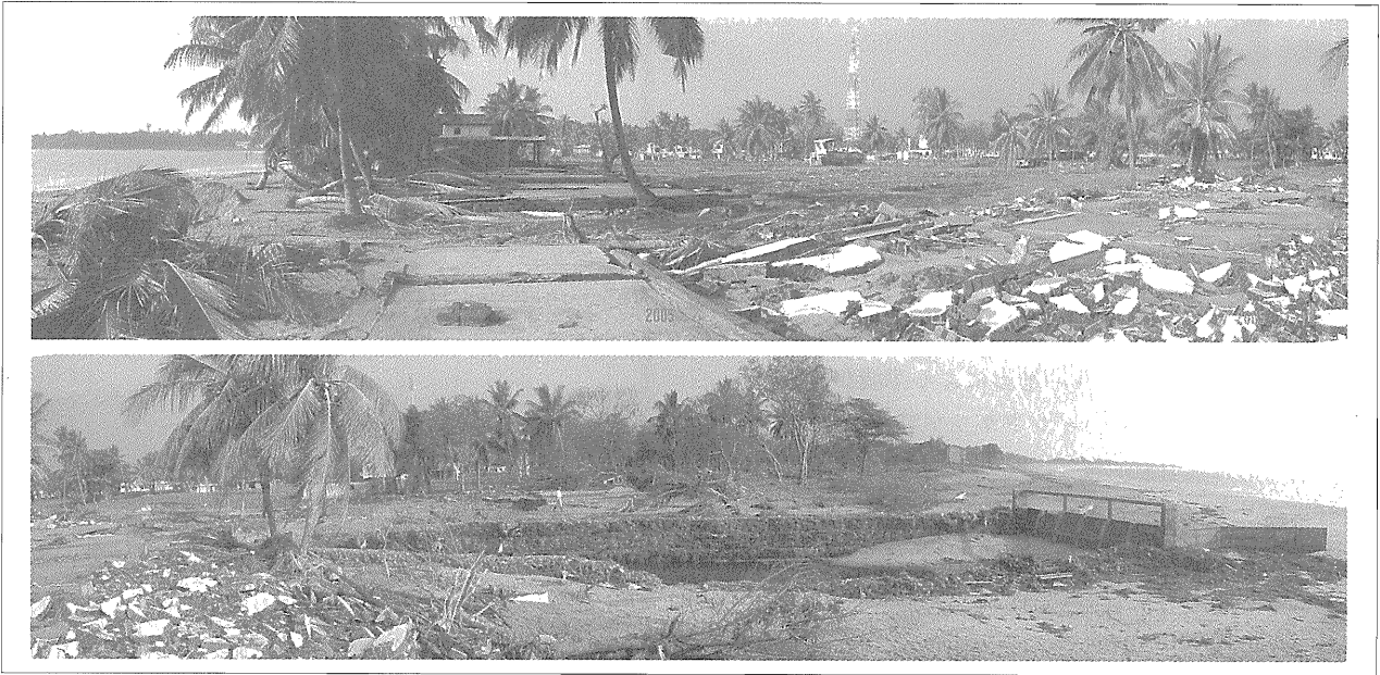
写真一 Hambantota 市の被災状況
