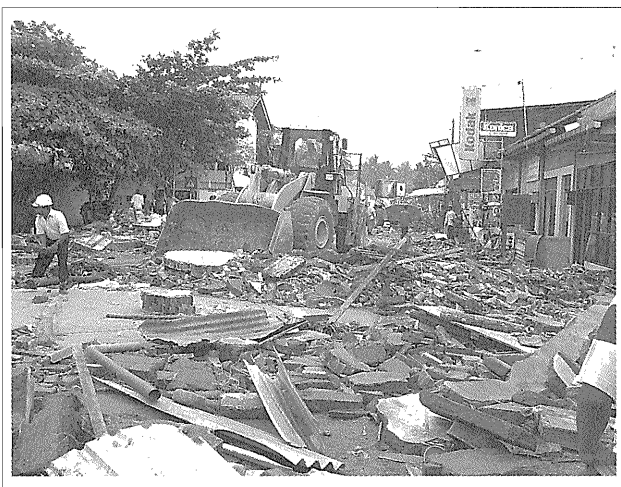
写真—6 国道 2 号線の瓦礫の撤去
