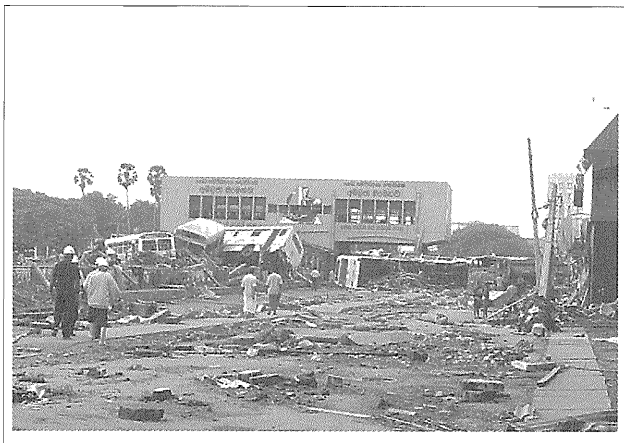
写真二 路上に横転した大型バスはホテルの前で積み重なっている
