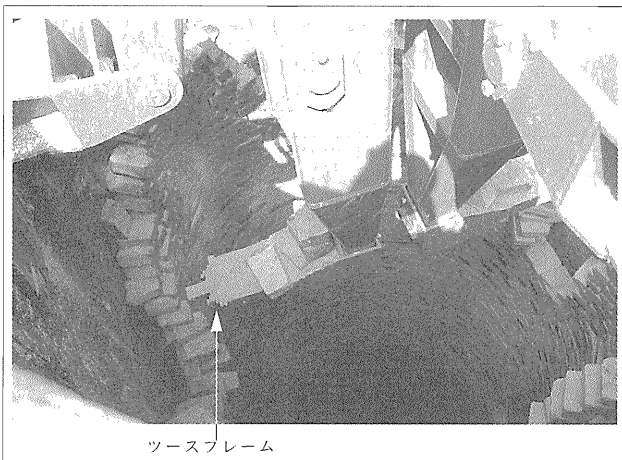
写真-1 煙突内煉瓦解体状況
