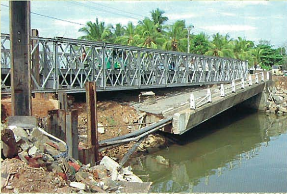
↑G-8 応急組立橋(ゴール)
