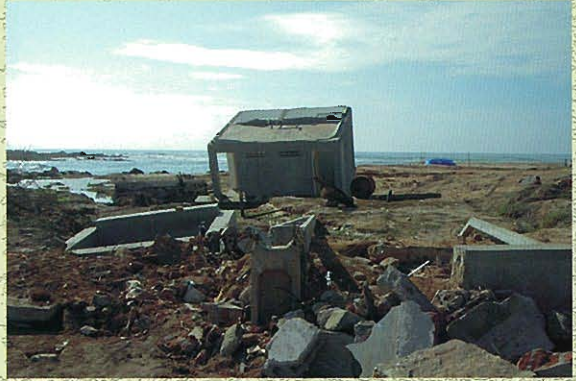
↑G-9 港湾施設の被害(タンガッラ)
