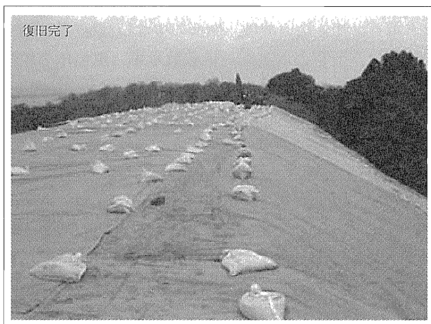
写真-12 応急復旧後の堤防（三俣野地先）
