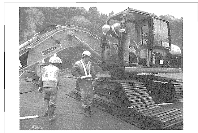
写真—9 現地組立て作業
