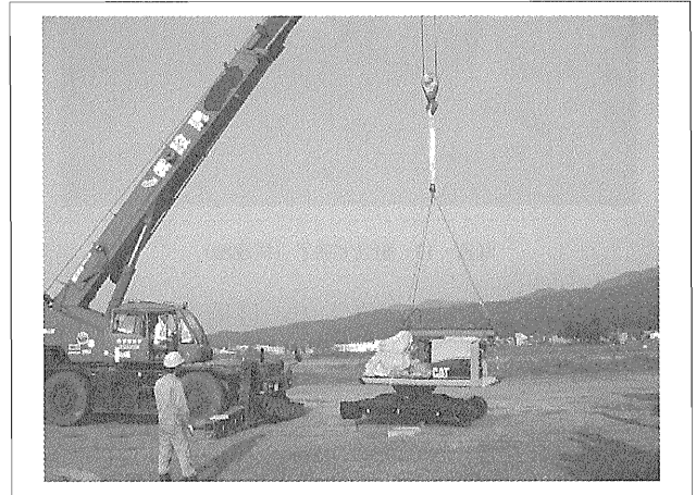
写真—7 現地での吊り試験
