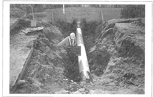
写真-4 横断排水管復旧
