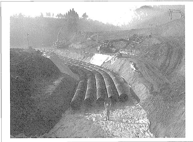
写真-10 仮設排水管敷設完了
