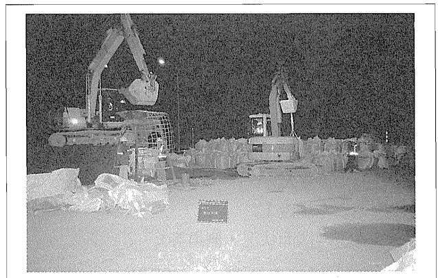
写真-3 夜間大型土のう製作
