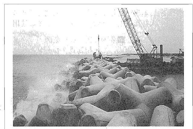
写真-6 消波ブロック式防波堤
