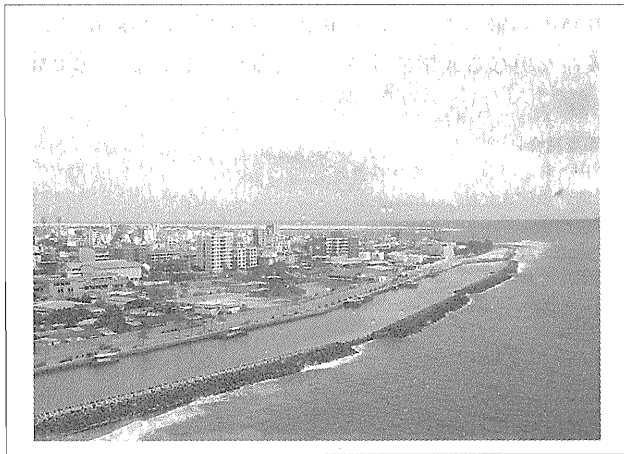
写真-1 マレ島南防波堤と南護岸
