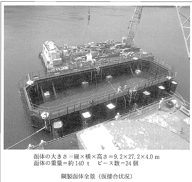
写真-2 鋼製函体全景
