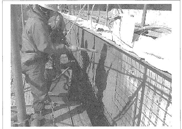
写真-4 吸音材吹付け作業状況
