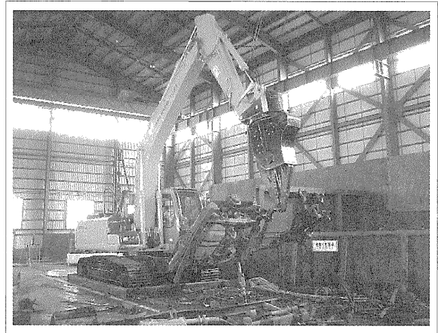
写真—3 屋内で稼働する ZX 200 電動式自動車解体機
