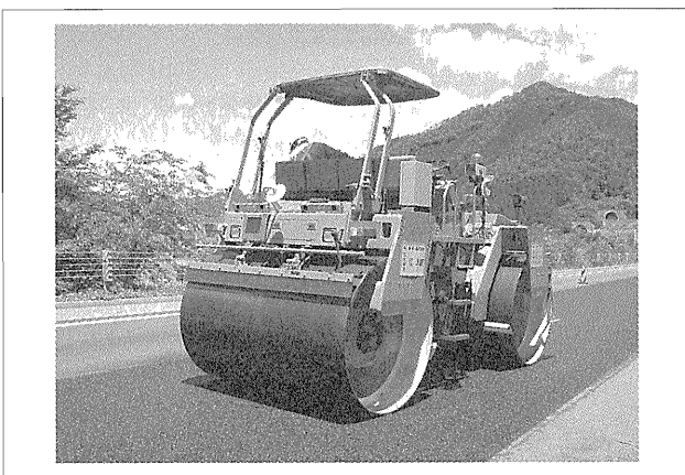
写真-6 ワイドローラ「SW 720 B 改」(高速道路切削オーバーレイ工事における高機能舗装を転圧中)
