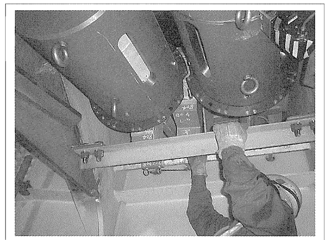
写真-5 座金、シム調整状況
