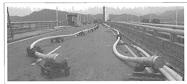
写真—8 再生が完了したケーブル
