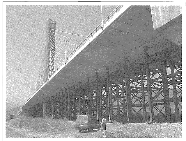
写真一4 ベントの設置状況
