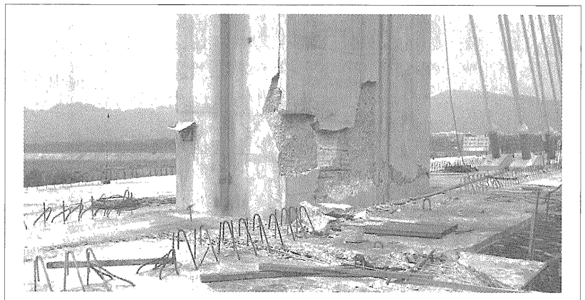
写真-1 主塔基部
