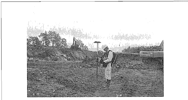
写真-1 3D-NAViによる測定状況
