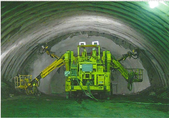
第二東名静岡第三トンネル工事の切羽
