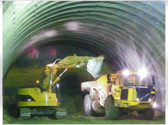
ローディングショベルによるADTへの積込み
