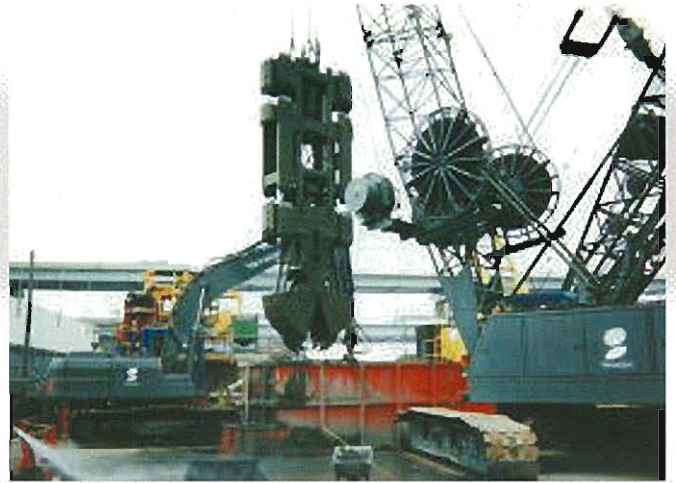
バケット式掘削機による連壁工事
