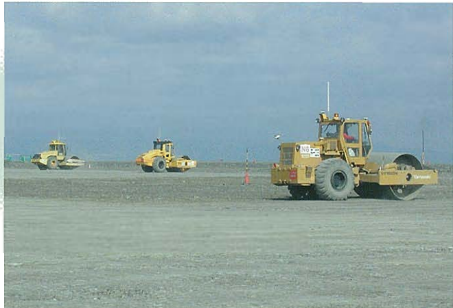
↑GPSによる締固め管理(全ローラに装着)
