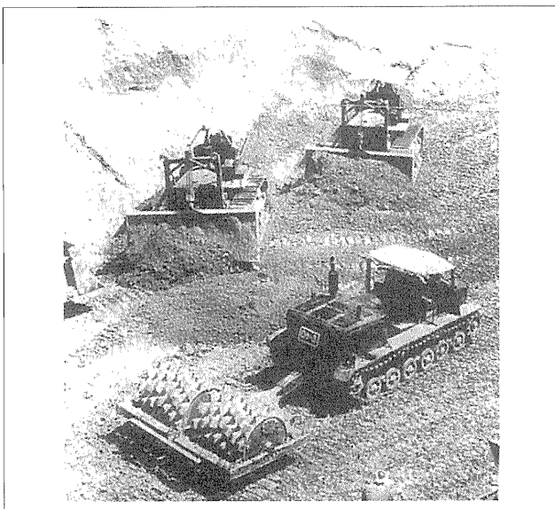
写真一3 信濃川発電所コア締固め
