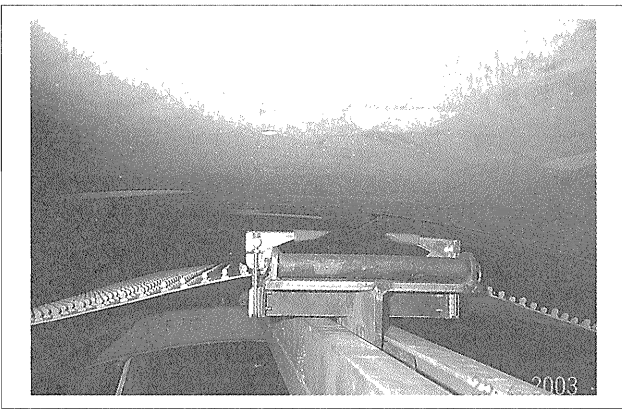
写真-9 ワンタッチグループにより防食シートの引込み
