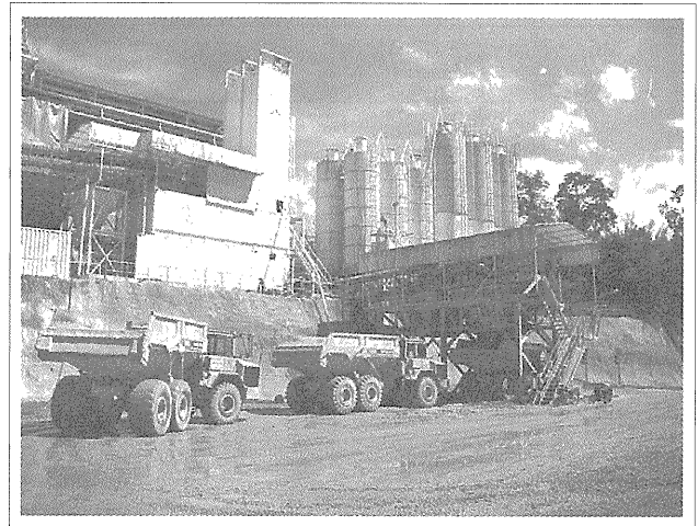
写真-2 連続練りプラント・サイロ
