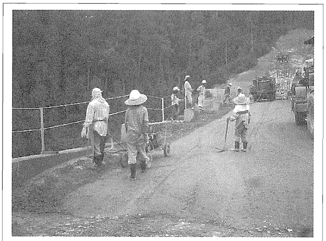
写真-7 下流面ブロック型枠
