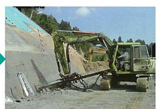
復旧状況(H17.9.23)
