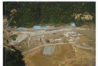
復旧状況(H17.10.12)
