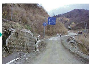
応急復旧状況(H16.12.21)
