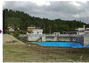
現在の復旧状況(H17.10)
