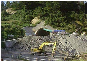
工事状況(H17.9.29)
