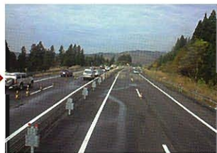
4車線化工事完了(H16.11.26)
