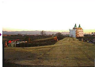
仮締切堤完了(H16.12.3)
