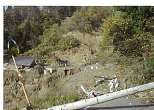
被災状況(H16.11.5)
