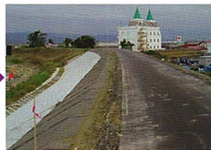
復旧工事完了(H17.10.6)
