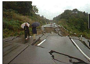
被災状況(H16.10.26)
