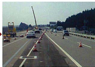
本復旧状況(H17.9)
