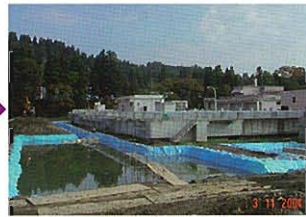
仮復旧完了(H16.11.3)
