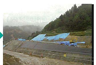
復旧状況(H17.9.30)
