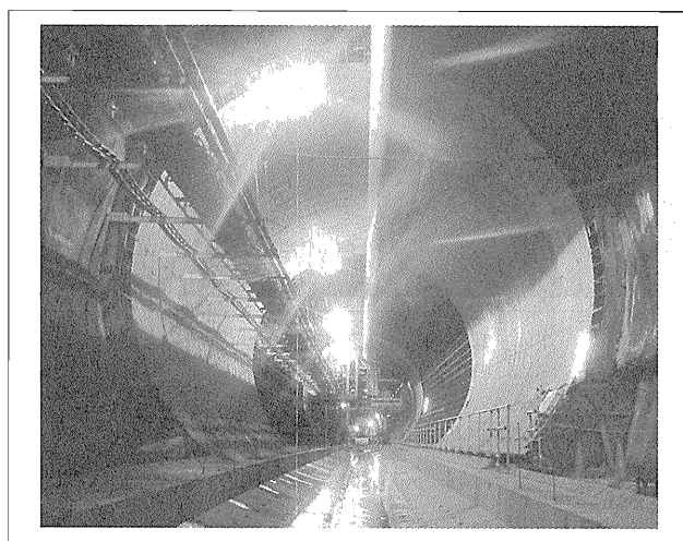
写真-2 アーチライナ施工状況
