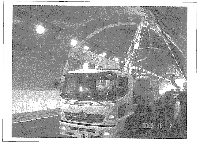
写真-2 調査専用機による調査状況
