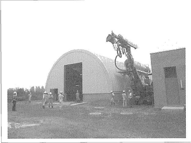
写真—7 模擬トンネル外観
