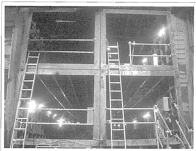
写真—2 4 函体推進完了状況
