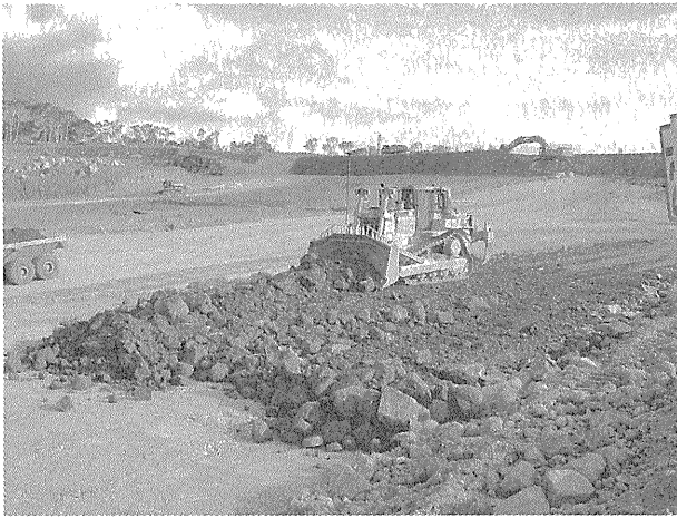
写真-3 3D-MC ブルドーザ施工状況
