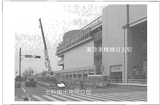
写真-1 土砂搬出場所全景
