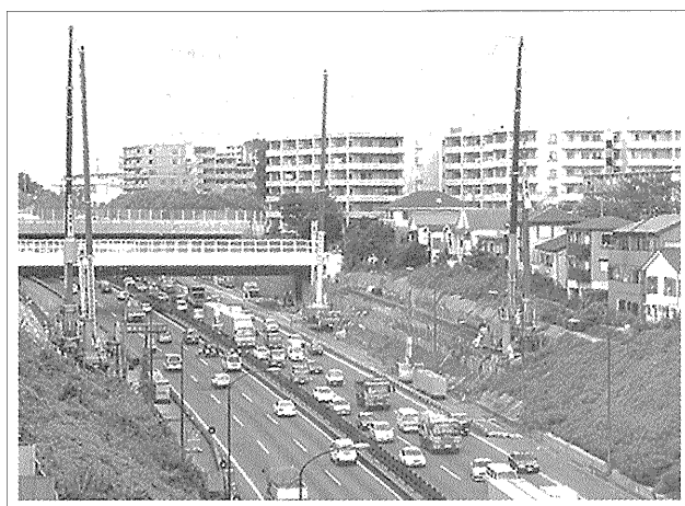
写真—7 ノン・ステージング工法（道路拡幅）
