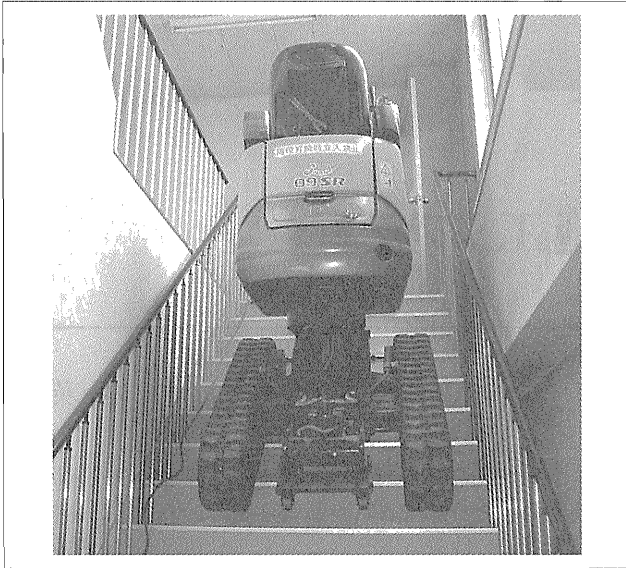
写真-5 階段を昇降する解体機
