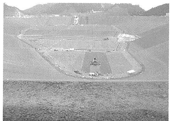
写真—4 小丸川上部調整池全景（貯水620万m 3 ）
