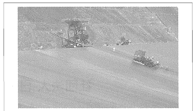
写真-7 レーザ誘導式自動操舵アスファルトフィニッシャ
