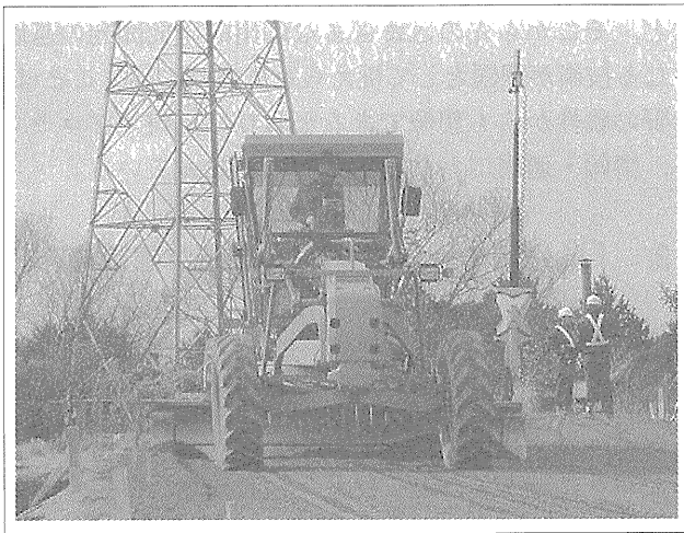
写真—2 現在の三次元重機制御システムによるグレーダ作業
