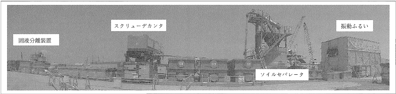
写真-6 現場全景
