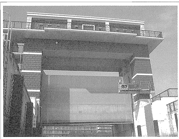
写真一1 閘門内の船上から見た荒川ロックゲートの旧中川側ゲート
