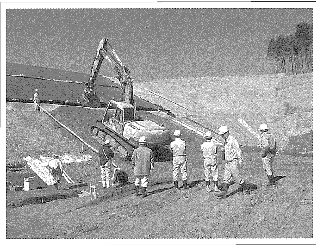
写真-2 ベントナイト混合土の施工（法面部）
